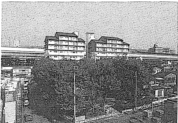
①・② 新在家南町3丁目A・B 共同再建完成写真
