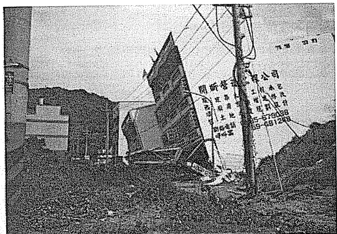
活断層上の建物が倒壊（99年9月26日、豊原郊外）
