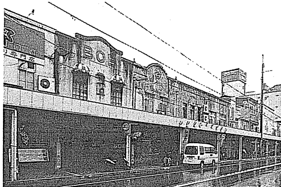
大開通の協調再建ビル
