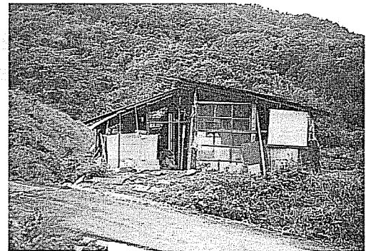
新しく家が建つまでの藤嗣さんの仮設住宅
