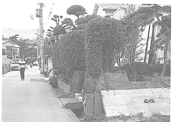
写真2 倒壊した手前のブロック塀と対照的な生け垣（芦屋市）
