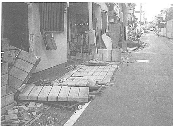
写真1 倒壊したブロック塀（神戸市）（筆者撮影・以下同様）
