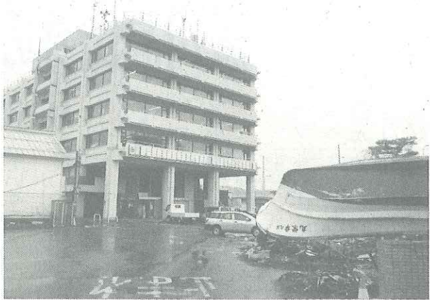
宮古市役所の被害状況
