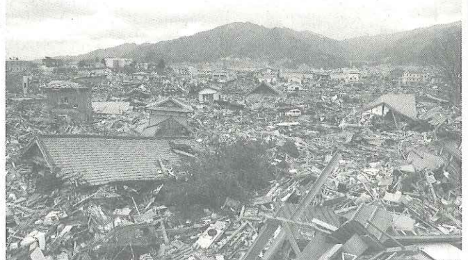
赤崎地区の被害状況
