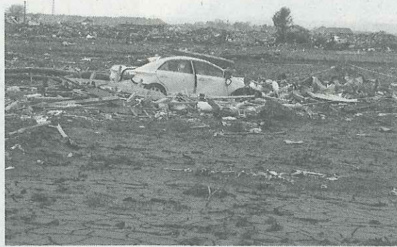
平地型(農地型)の被害—仙台市若林区
