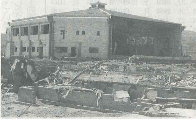
陸前高田市の被災した市民体育館
