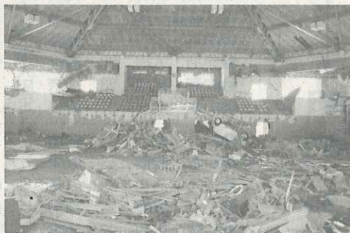
陸前高田市の被災した市民体育館内部
