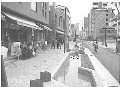
写真5・2 主要コミュニティ道路（アジア通り）
