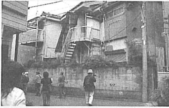
ダメージポイントー古い塀や建物が密集し、倒壊や延焼火災の危険を感じる箇所が多くある
