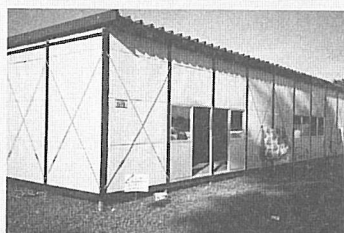
神戸で使用された応急仮設住宅と同型 のものを建設
