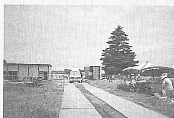
鉄板を敷いて仮設の道路もつくる
