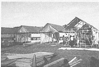
建設現場で使用される単管とブルーシ ートを組合せ、パイプ住宅を設置
