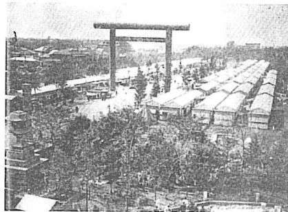
図 2-2 靖国神社前の仮設住宅 (出典：東京市『東京大正震災誌』1925年)
