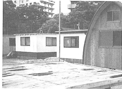
図2・9 本町公園内には自力建設で仮設住宅が 建てられた（兵庫区）
