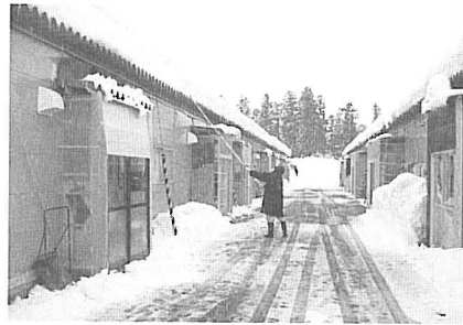
図 2・21 仮設住宅と積雪への構え
