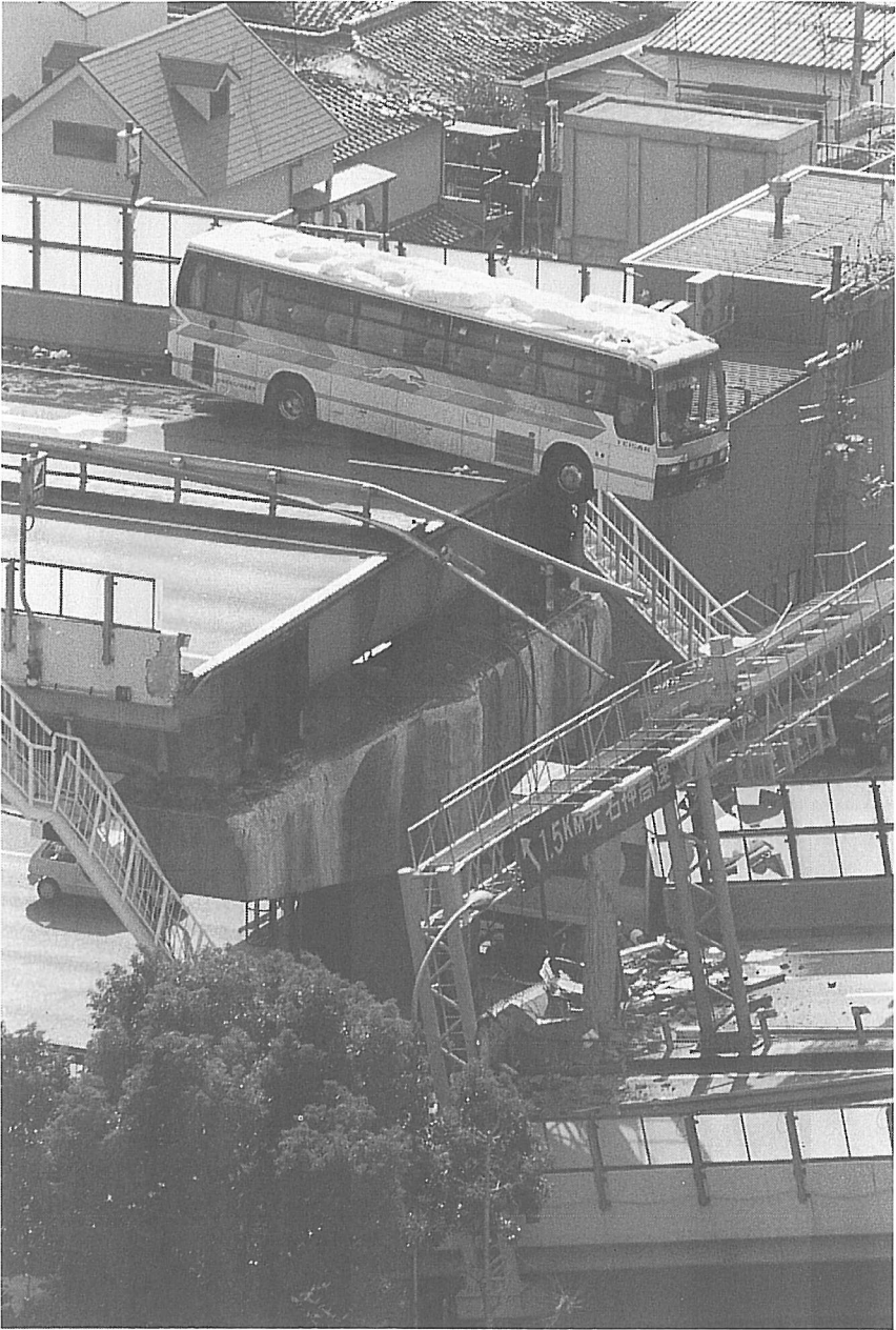
阪神高速神戸線の高架橋倒壊に巻き込まれて転落寸前のバス＝7年1月17日、神戸市東灘区
