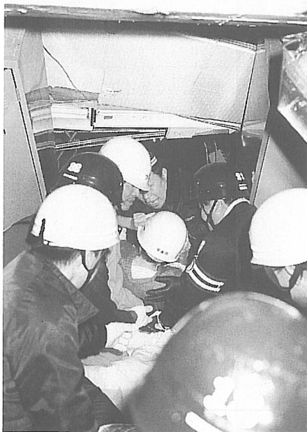
天井が落ちた病室から救助される被災者。震災直後は恐怖にさいなまれ、氣力を失った人も11月17日、神戸市西区の市立西市民病院
