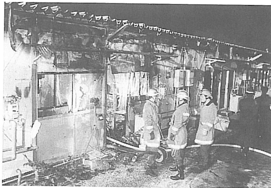
火災で焼失した仮設住宅。防犯・防火面で心配されていたが…118年10月22日、神戸市北区
