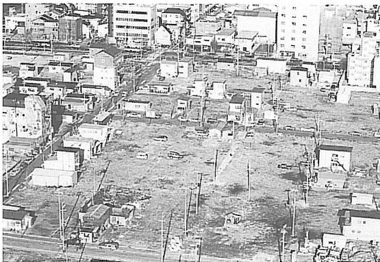
震災後の火災で大被害を受けた神戸市長田区の鷹取地区。さらに地に仮設建物が目立ち始めた119年1月6日
