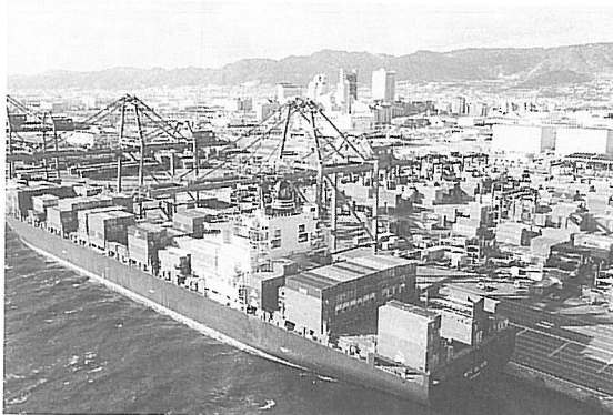
震災から2年が経過した六甲アイランド・コ ンテナベース。設備もようやく震災前に戻り つつあった119年1月6日、神戸市東灘区
