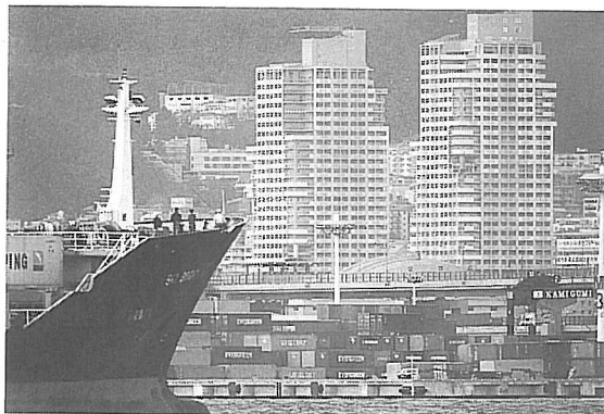
建設された復興住宅。だが、被災者の希望と 現実の住宅供給はなかなかみ合わなかった 11年12月、神戸市中央区
