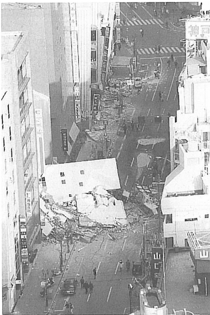
倒壊したビルが道路をふさぐ。17年1月、神戸市中央区
