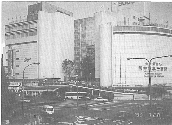
写真1 そごう百貨店の再生。 JR三宮駅と百貨店をつなぐ歩道橋をいかし、百貨店側にセットバックした広場を設けたもの。(次ページ共)
