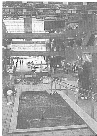
写真8 ▶ 西神ニュータウン 中央センター
