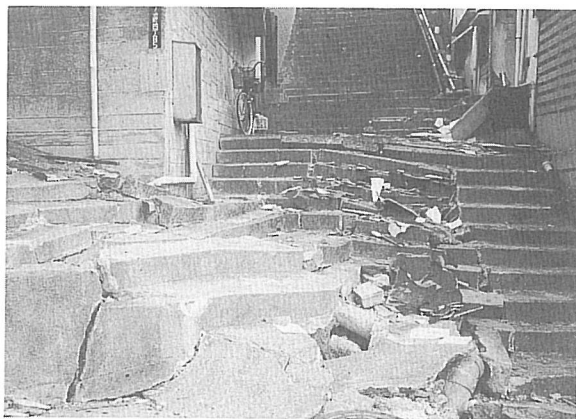
写真13 傾斜地の市街地には階段状の路地があるが、階段状の生活道路にも大きな被害が出た
