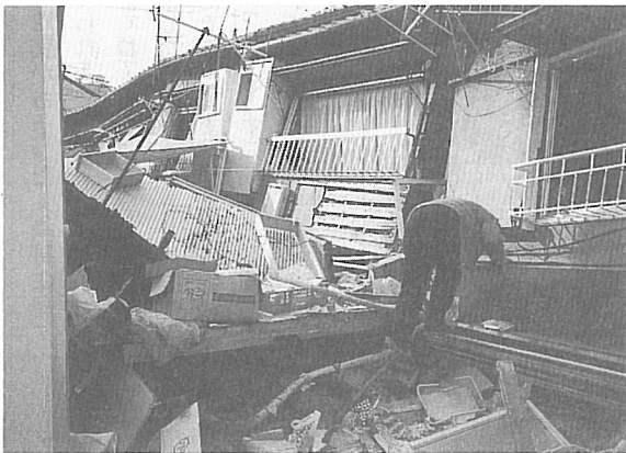
写真15 全壊した木造アパート。多くの高齢者や障害者が入居していた木造アパートが全壊し、被害者が多かった
