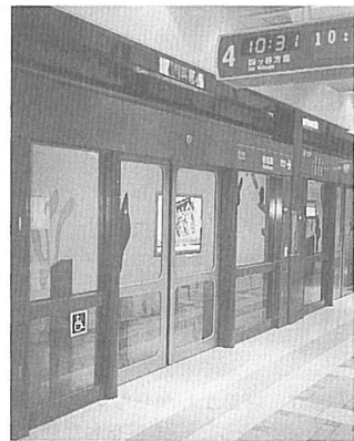
写真5 スクリーンのついた地下鉄プラットフォーム。乗降客のプラットフォームからの転落事故の可能性は少なくなった（営団地下鉄南北線、後楽園駅）
