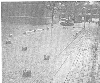
写真6 おしゃれであるが危険な車止め。床面と同様の材料で作られた車止めは視覚障害者にとってはつまづいたり転倒のおそれのある危険なバリアである
