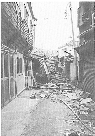
◀ 写真2 住宅の倒壊でふさがった生活道路
