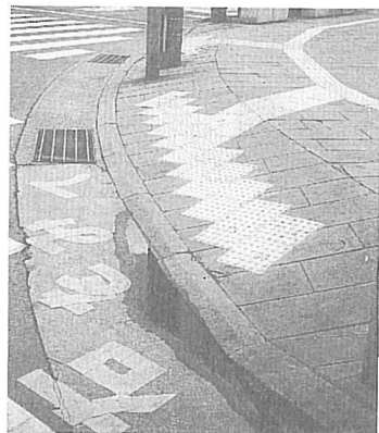
写真3 交差点の段差切り下げ部分の傾斜地に敷設された点字ブロック
