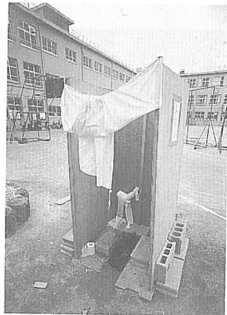
写真10 ▶ グラウンドに 掘ったトイレ
