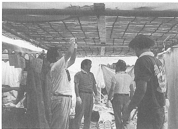
写真9 岩屋公園のテント村の夏期対策用のよしずのシェルター設置作業
