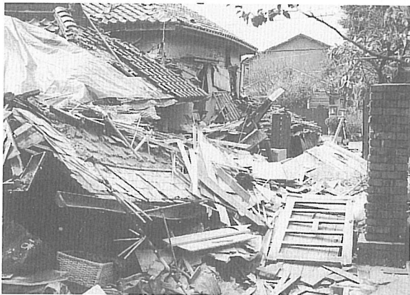
写真1 老朽木造住宅の倒壊。 既成市街地には戦前や戦後間もない頃に建てられた木造住宅が多かったが、震災でその多くが倒壊した
