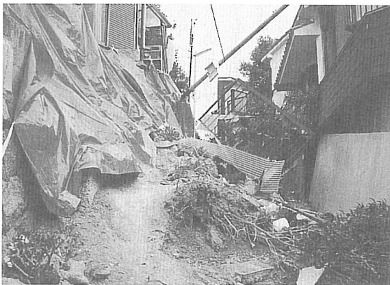
写真12 倒壊した住宅でふさがれた道路
