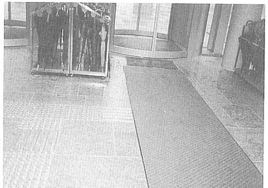
写真10 点字ブロックをおおってしまった玄関マット。せっかく敷設した点字ブロックが利用できない
