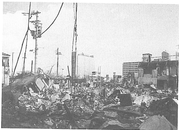
写真1 震災により壊滅した街（神戸市長田区）
