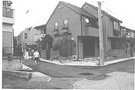
図 7・5 6 差路部分を整備中の川面地区の密集事業
