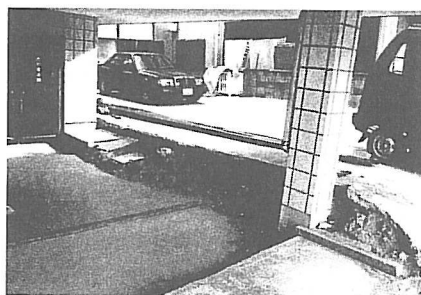
図4・5 液状化現象による建物沈下(尼崎市撮影)
