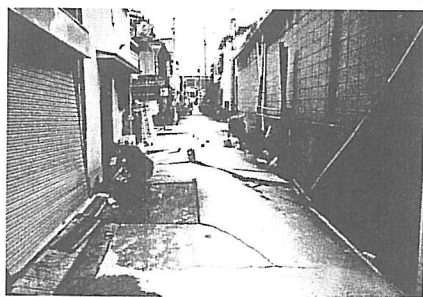
図4・4 液状化現象による路面崩壊と建物沈下(尼崎市撮影)
