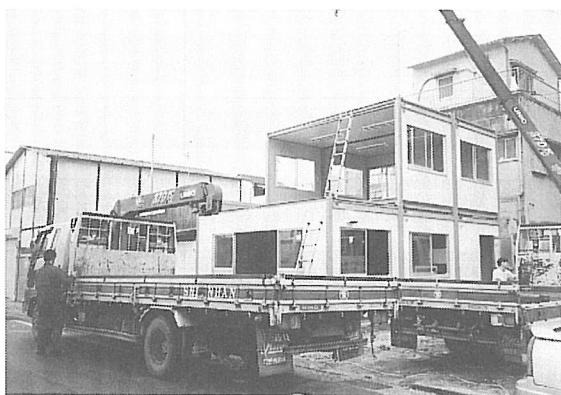
図12・9 建設中の仮設工場
