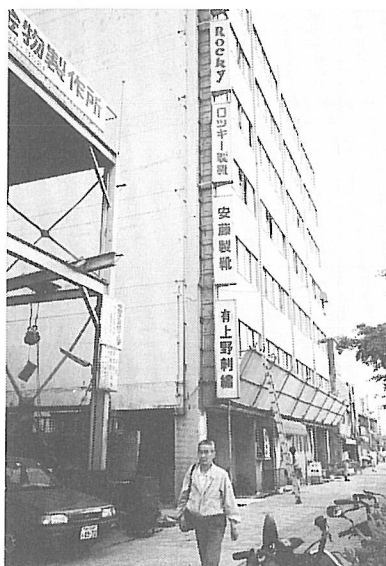
図 12・15 修繕して再開している古い民間工場アパート
