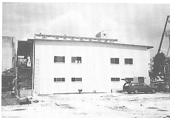
図12・10 大規模な仮設工場
