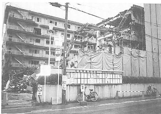
図 12・4 全壊し解体中の化学センタービル
