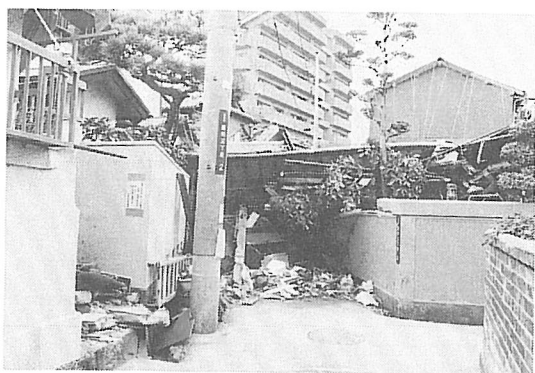
震災3ヶ月後でも道路が封鎖されている
