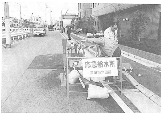
早期復旧の本管からとって給水している
