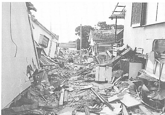
図2・1 道が完全にふさがれてしまっている芦屋地区の被害
