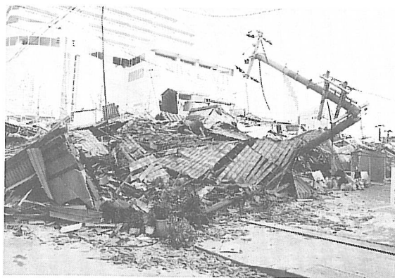
図1・2 各所で折れ、倒壊した電柱被害
