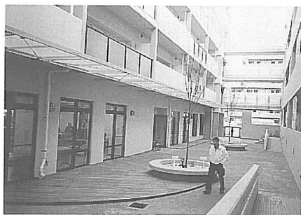
図11 住宅完成時に神戸市から渡された路地広場の風景(花植えワークショップ前)
