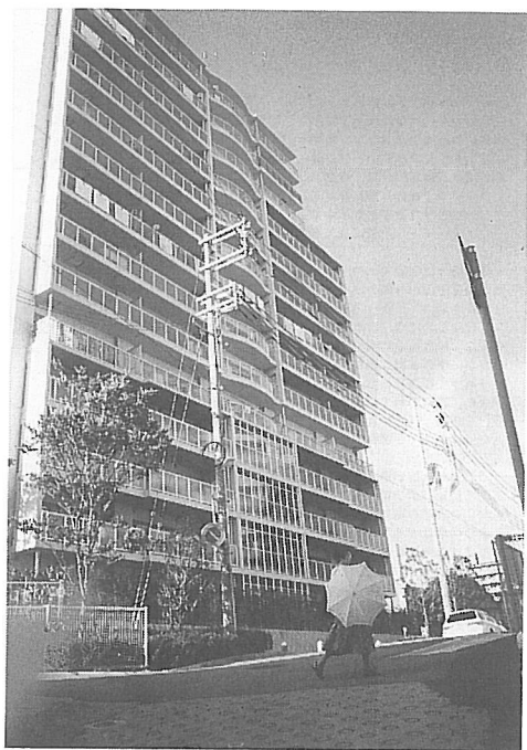
図5 大倉山ふれあい住宅の外観、1階から4階がふれあい住宅の住戸
