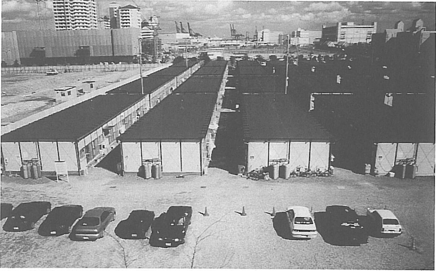
図7 神戸市六甲アイランドに建設された一般仮設住宅群
