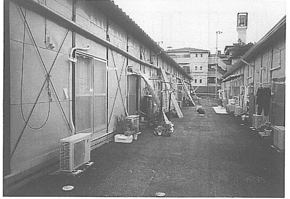
図2 芦屋市呉川町の高齢者・障害者向けケア付地域型仮設住宅の外観
