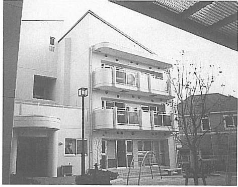
図26 岩屋北町ふれあい住宅の共同玄関(写真の左端)
